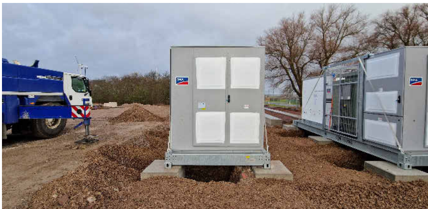
Wechselrichter- und Trafostationen mit jeweils 4 MW werden für das Referenzprojekt in Waltershausen installiert. Foto: Tauber Solar
