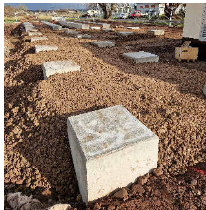
Fundamente für über 20 t Lasten entstehen beim Referenzprojekt in Waltershausen. Foto: Tauber Solar
