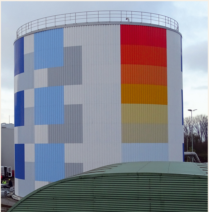
Bild 5 Pufferspeicher aus Edelstahl rostfrei speichern und stellen erzeugte Wärmeenergie bereit. Foto: WZV / Lipp
