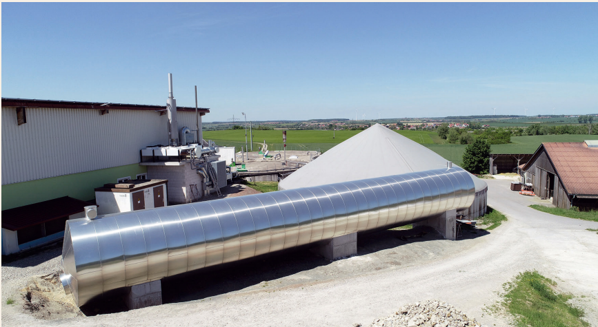
Bild 6 Bewährter Werkstoff für die Konstruktion von Pufferspeichern ist Edelstahl Rostfrei, der bei hohen Temperaturen dünnere Wandstärken von Rohren, Behältern und Apparaten erlaubt. Foto: WZV / Hans van Bebbber Heizungsbau
