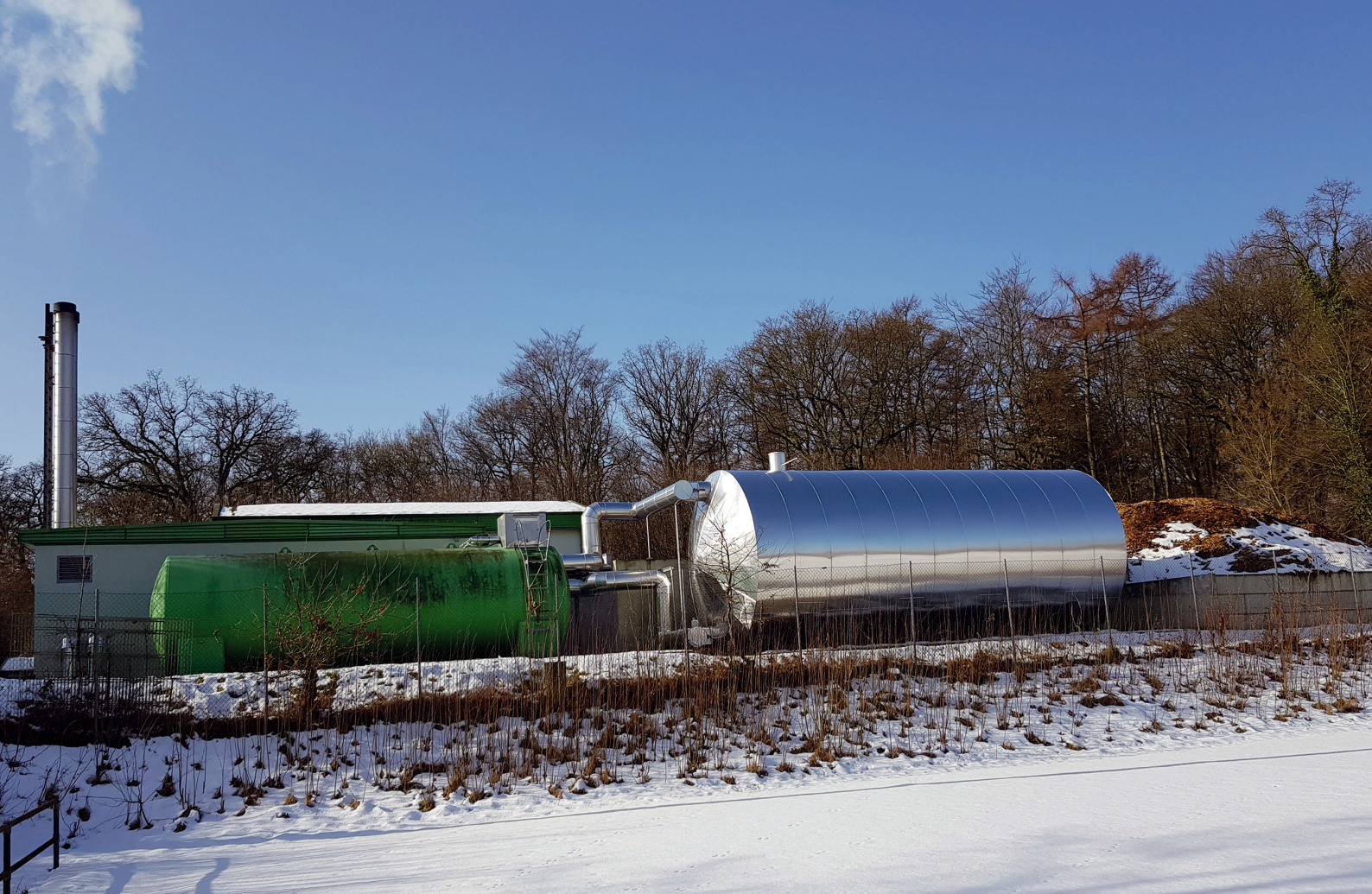
Bild 1 Die werkstofftypischen Eigenschaften von Edelstahl Rostfrei machen ihn zum bewährten Klassiker für Hochtemperaturspeicher. Foto: WZV / Hans van Bebber Heizungsbau
