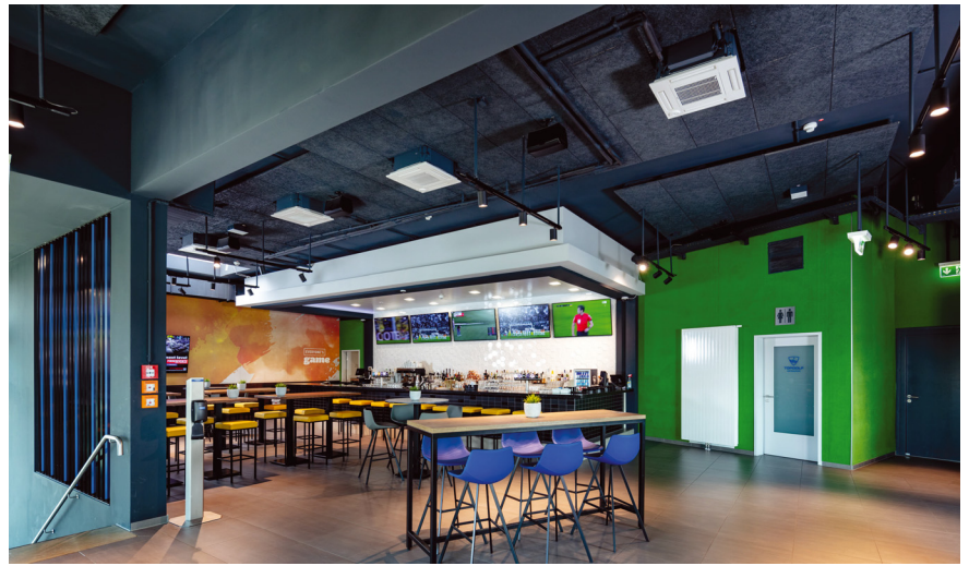
Der horizontale Luftausblas sorgt für eine optimale und für Nutzende nahezu zugluftfreie Durchströmung der zu klimatisierenden Räume. Foto: Mitsubishi Electric
