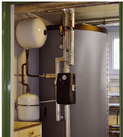
Die Solaranlage produziert während des ganzen Jahres Warmwasser, das in einem Schichten-Pufferspeicher zwischengespeichert wird. Foto: Wolf GmbH
