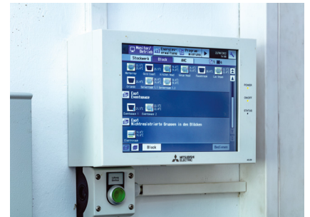
Das Zentralsteuerungssystem bietet die Möglichkeit des Fernzugriffs via Smartphone-App oder Internet, um beispielsweise den Betriebszustand oder eine eventuelle Fehlerdiagnose auszulesen. Foto: Mitsubishi Electric
