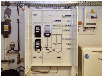
Überschüssige Energie der PV-Anlage wird in einem Batteriespeicher mit 25,2 kWh Ladekapazität gespeichert. Foto: Wolf GmbH
