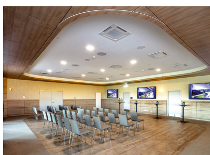
Die Innengeräte sind mit 3D-i-see-Sensor-Technologie für eine intelligente Klimatisierung ausgestattet. Der Sensor erkennt die Anwesenheit von Personen im Raum und passt die Temperatur entsprechend an. Foto: Mitsubishi Electric
