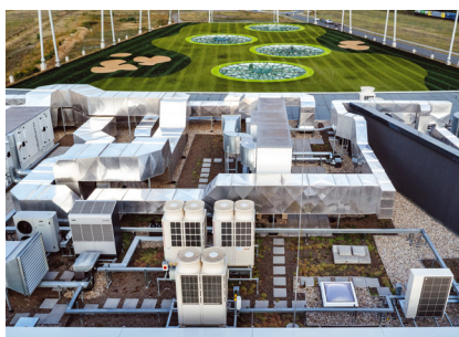
Das eingesetzte City Multi VRF-System verfügt über eine integrierte Wärmepumpenfunktion und ermöglicht über eine Umschaltfunktion wahlweise den Kühl- oder den Heizbetrieb. Foto: Mitsubishi Electric
