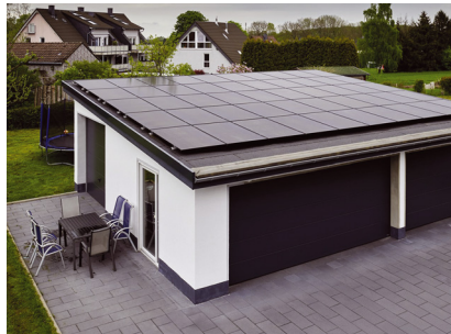
Die aus 50 Modulen bestehende PV-Anlage auf einem Nebengebäude hat eine Leistung von 21 kWp. Foto: Wolf GmbH
