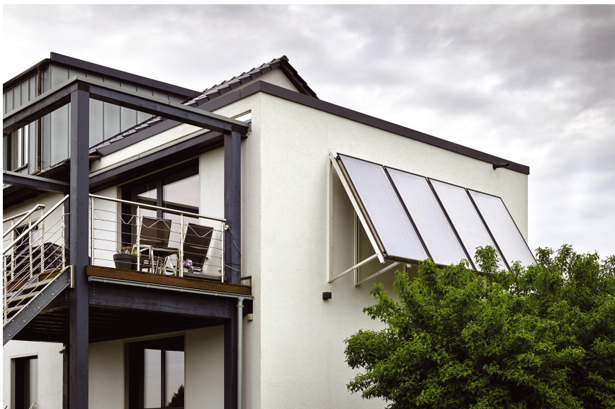
Im Rahmen des letzten Umbaus mussten die auf dem Dach befindlichen Solarthermie-Module an die Fassade „umziehen“. Foto: Wolf GmbH
