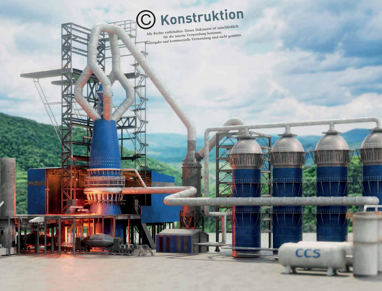
**Bild 1** Durch die Integration von Hochofen und Kokerei sowie das konsequente Recycling von Prozessgasen und -wärme kann der CO<sub>2</sub>-Ausstoß bei der Stahlproduktion reduziert werden. Foto: SMS group
