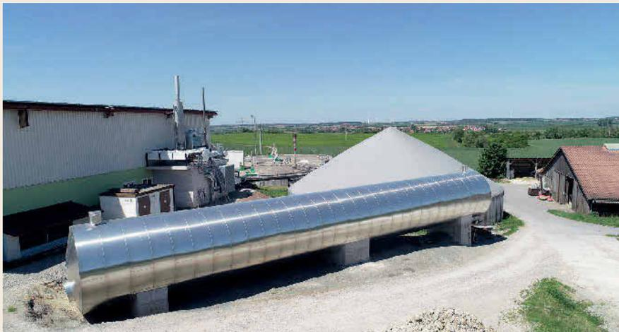
**Bild 6** Bewährter Werkstoff für die Konstruktion von Pufferspeichern ist Edelstahl Rostfrei, der bei hohen Temperaturen dünnere Wandstärken von Rohren, Behältern und Apparaten erlaubt. Foto: WZV / Hans van Bebber Heizungsbau
