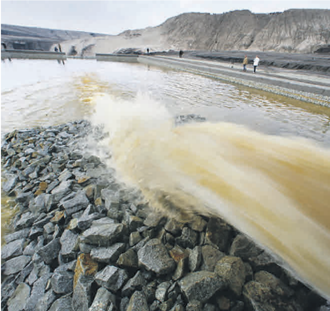
Wenn Tagebaulöcher geflutet werden, verändern sich Wasserchemie und Strömung des Grundwassers; im Bild die Flutung des letzten DDR-Tagebaus Meuro in Brandenburg im Jahr 2007. Foto: Michael Urban/ddp images
