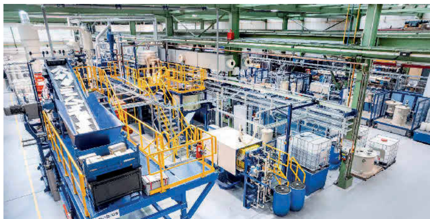
Bild 2. Blick auf die Lithium-Ionen-Batterien-Recyclinganlage am Standort in Hilchenbach. Foto: SMS
