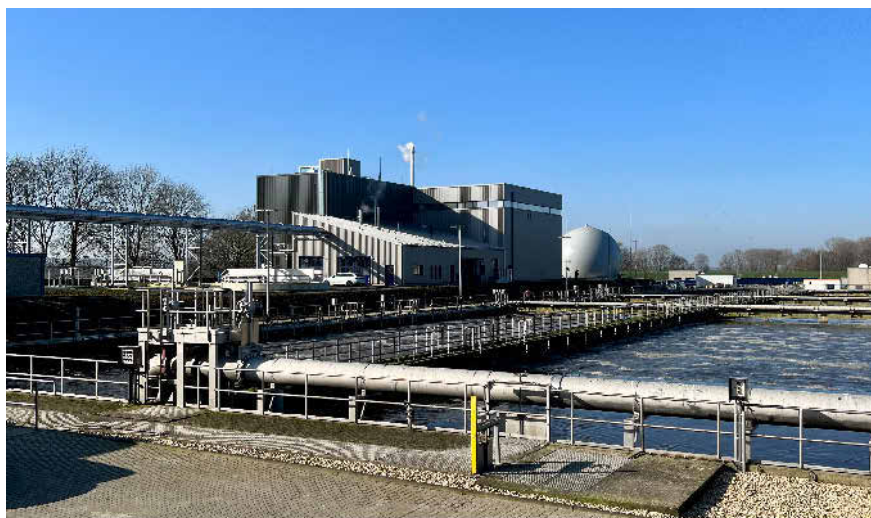
Die Pyreg-Klärschlammmanlage PX0750, die im März 2023 als Teil einer neuen Thermokompaktanlage im Klärwerk Kleve-Salmroth in Betrieb genommen wurde. Bei einem Input von stündlich bis zu 300 kg Klärschlamm werden in der Anlage bis zu 100 kg Karbonisat generiert – bei einer zusätzlichen Wärmeleistung von etwa 250 kW th . Foto: Pyreg
