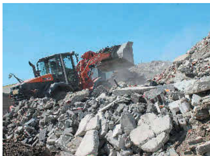
Der Bauschutt abgerissener Häuser wird wie hier auf der Bauschuttrecyclinganlage Büscher in Heek vorsortiert, um dann wieder eingesetzt zu werden. Foto: Betonwerk Büscher
