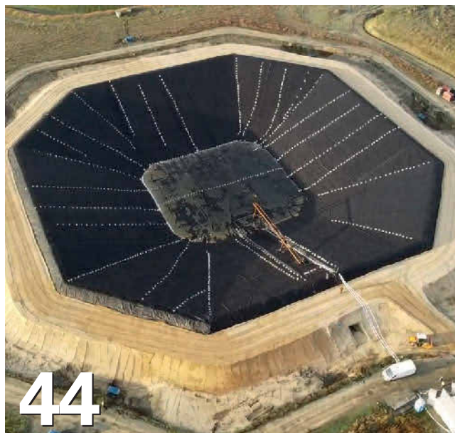
Der erste Erdbeckenspeicher in Deutschland entsteht in Schleswig-Holstein. Bis zu 95 °C heißes Wasser wird dort gespeichert werden, um eine Kommune mit Fernwärme zu versorgen. Foto: NDR
