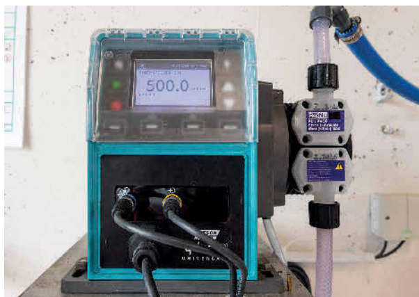
Die neue Schlauchpumpe Qdos 60 PU dosiert effizient, sicher und zuverlässig polymere Flockungsmittel für die Wasser- und Abwasseraufbereitung. Foto: Watson-Marlow
