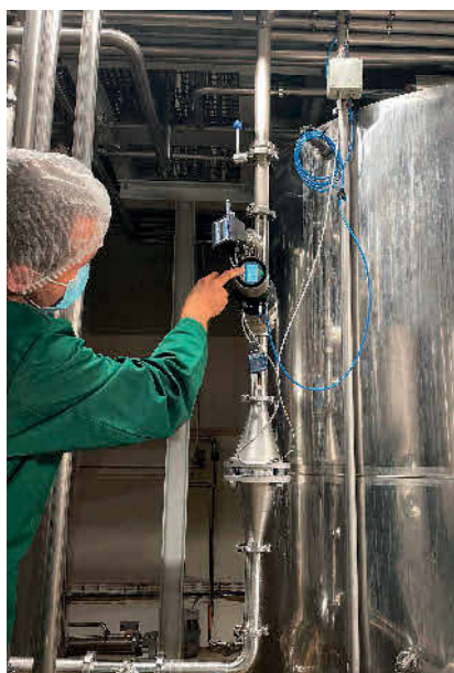
Die Regelstrecke lässt sich durch die Clamp-Anschlüsse einfach montieren. Foto: Biontis
