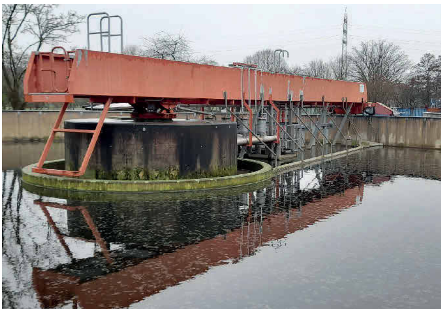
In diesem Nachklärbecken der Kläranlage Gifhorn entsteht der Überschussschlamm. Aus diesem Stoffstrom kann mit dem iPhos-Verfahren der Firma SF-Soepenber Phosphor mit einem Eisenaufschluss herausgelöst und Struvit ausgefällt werden. Foto: Klärwerk Gifhorn
