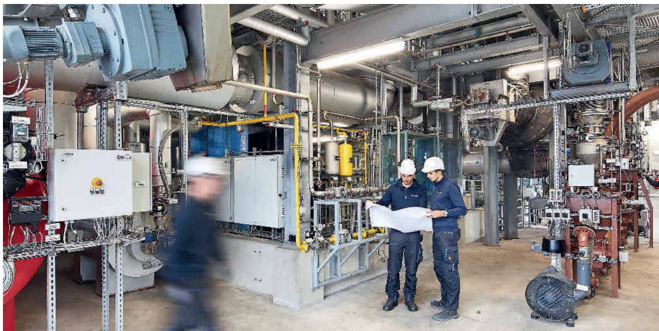
In dieser Klärschlammverwertungsanlage der Stadt Koblenz wird Synthesegas in einem Gasmotor eines Blockheizkraftwerks verstromt und sorgt für eine 95 %ige Energieautarkie des Klärwerks. Für die Synthesegas-Produktion wird ein Brenngas-Modul der Firma Kopf SynGas eingesetzt, das künftig in der energieintensiven Industrie eingesetzt werden soll. Foto: Kopf SynGas
