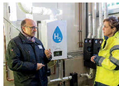
Remeha-Vertriebsleiter Franz Killinger und NRW-Wirtschaftsministerin Mona Neubaur vor einem Wasserstoff-Brennwertkessel.
