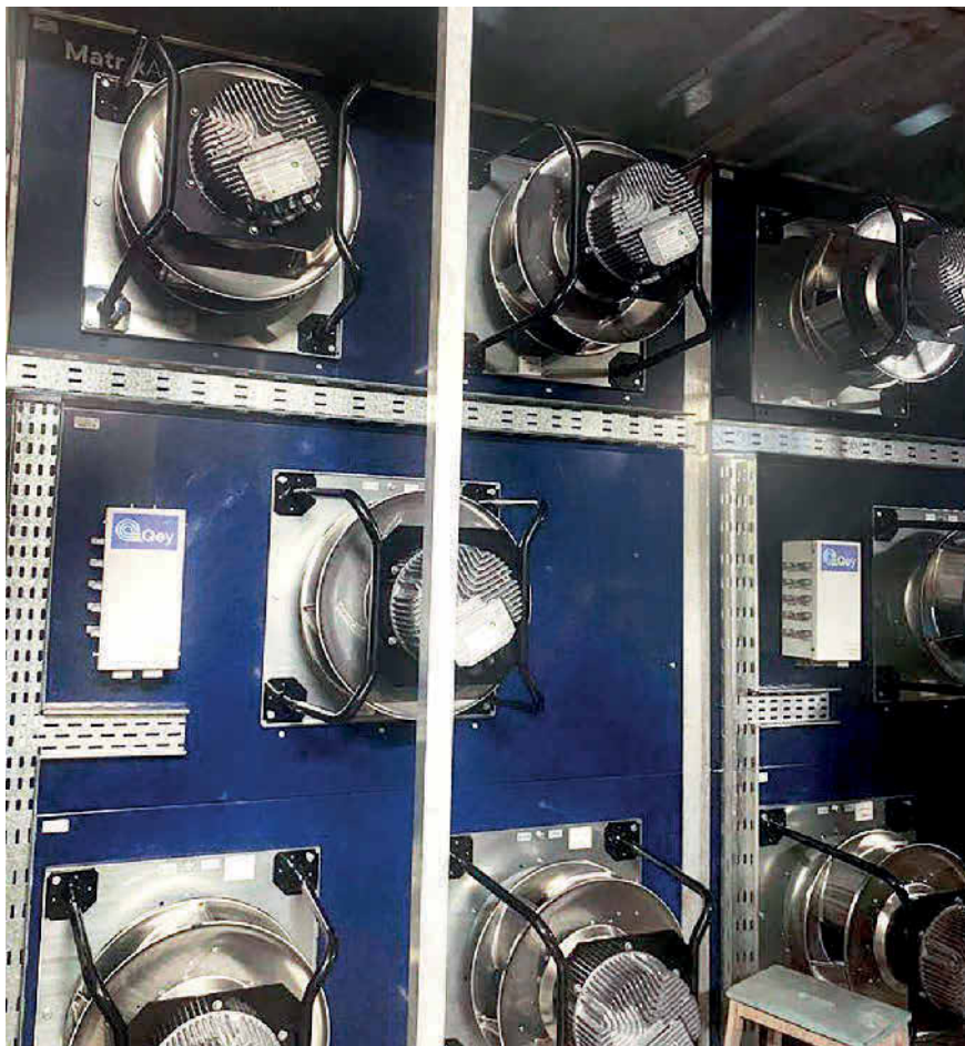
Bild 2: In jedem Kasten sitzt ein EC-Radialventilator. Gemeinsam bilden sie das FanGrid. Die Bauform sorgt für eine besonders hohe Betriebssicherheit. Foto: ebm-papst
