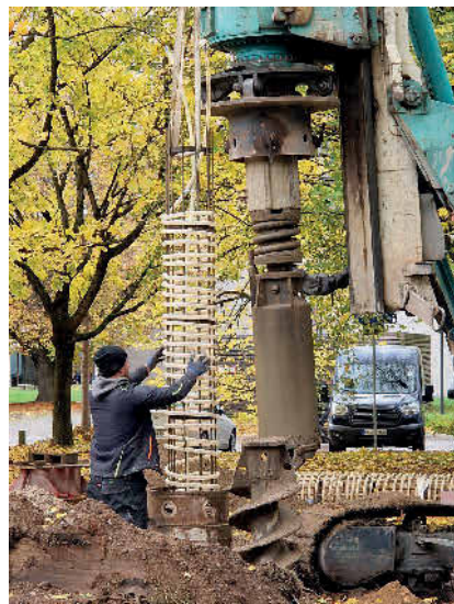
Bild 6: Einbau der Erdkörper am neuen Standort des KIT auf dem Campus Süd des KIT. Foto: Team RoofKIT
