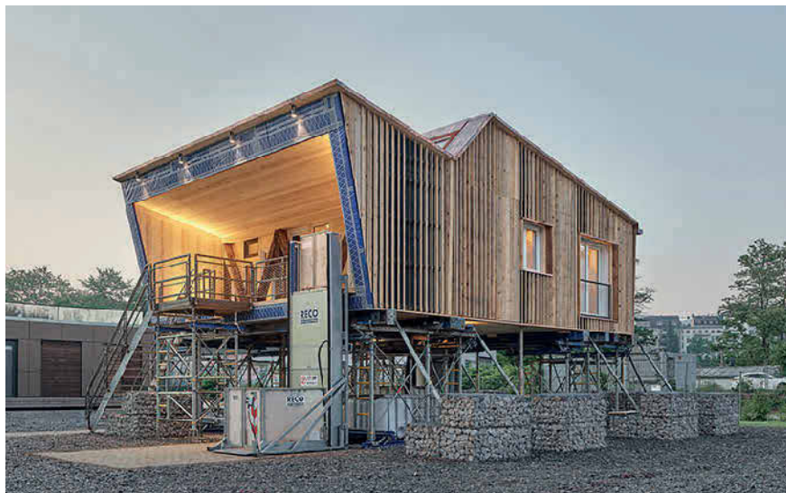
Bild 2: Ansicht der gebauten Gebäudeeinheit auf dem SDE-Wettbewerbsgelände in Wuppertal. Foto: Zoëy Braun
