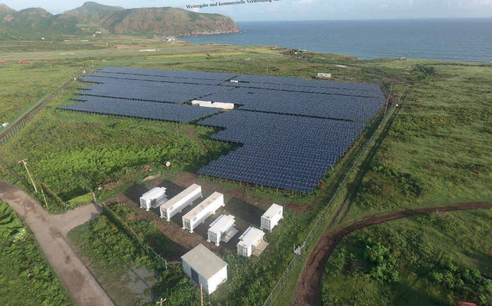
Bild 1 Das Vorgängerprojekt „PV-Diesel“ auf der niederländischen Antilleninsel St. Eustatius: Die intelligente Kombination aus Photovoltaik, Batteriespeicher sowie Dieselgeneratoren ermöglicht eine nachhaltigere Energieversorgung. Die Karibikinsel war zuvor vollständig auf Stromerzeugung aus Dieselgeneratoren angewiesen. Foto: SMA Solar Technology
