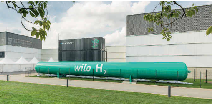
Die „H2Powerplant“ wird grünen Wasserstoff zur Energieversorgung des Wiloparks produzieren. Der Tank hat eine Gesamtlänge von 29,8 m, einen Durchmesser von 2,8 m und kann 520 kg Wasserstoff speichern. Foto: Wilo
