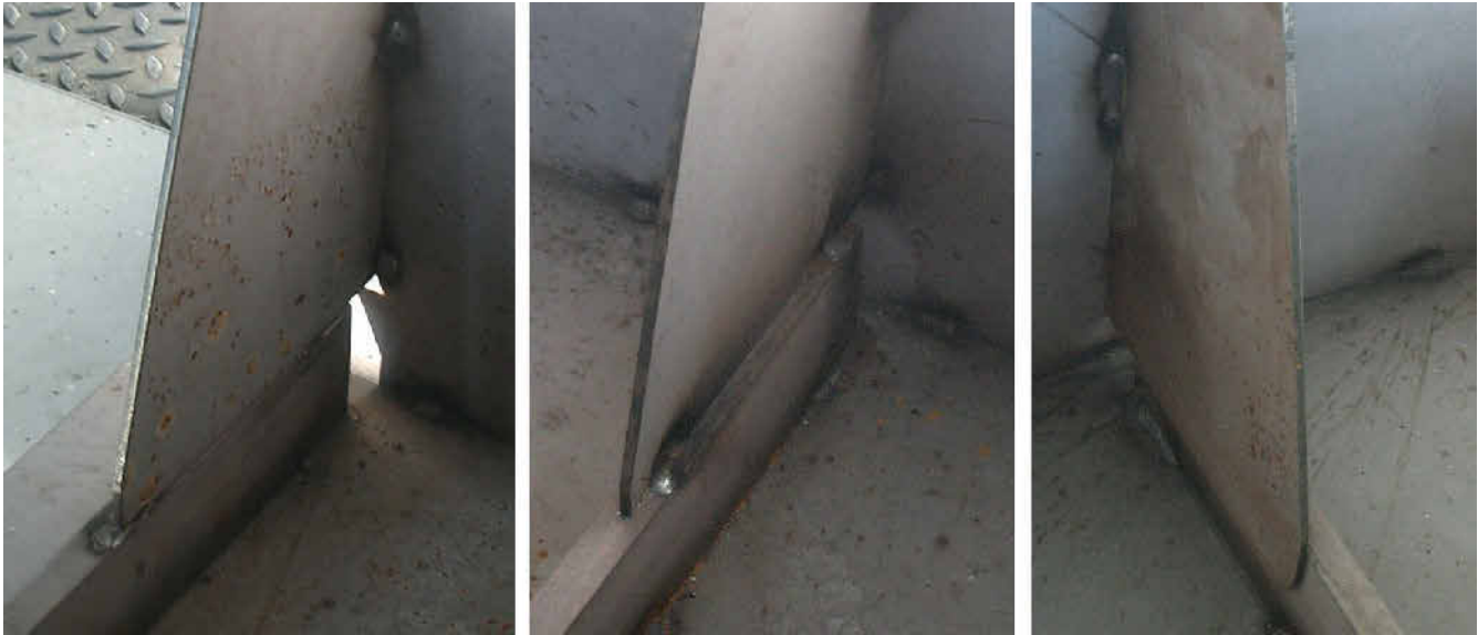
Bild 5. Anbindungsvarianten Kniebleche. Foto: Fraunhofer IGP
