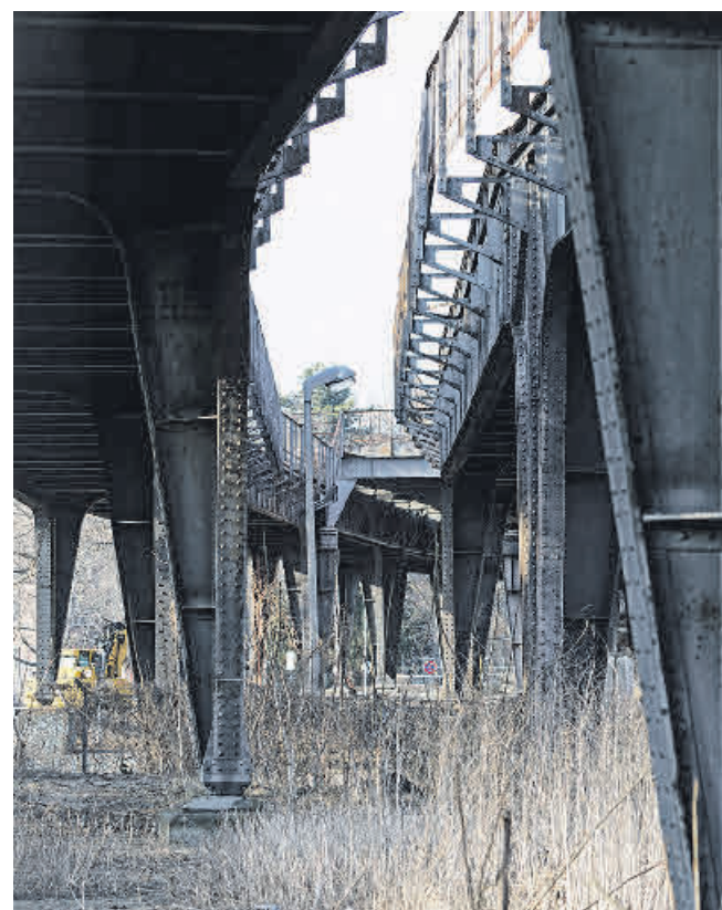
Das stählerne Viadukt der in den 20er-Jahren des vorigen Jahrhunderts erbauten, 1980 stillgelegten Siemensbahn der Berliner S-Bahn nahe dem Bahnhof Wernerwerk wartet auf seine Reaktivierung. Foto: Imago Images/Jürgen Heinrich
