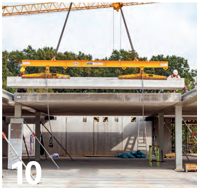
Der Verbundträger Deltabeam wirkt erst als Stahlträger und nach dem Ausbetonieren als Stahlverbundträger. Abb.: Peikko; Foto: 2-plus
