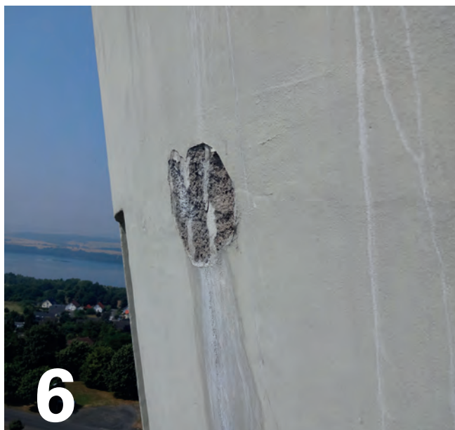
Bei der Bestandsaufnahme wurde der Wasserturm Borken gründlich untersucht. Abb.: SiB Ingenieurgesellschaft mbH
