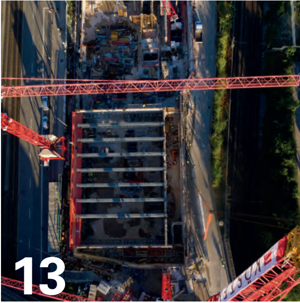
Acht Brückenträger erschaffen einen säulenfreien Ballsaal. Abb.: Köster GmbH
