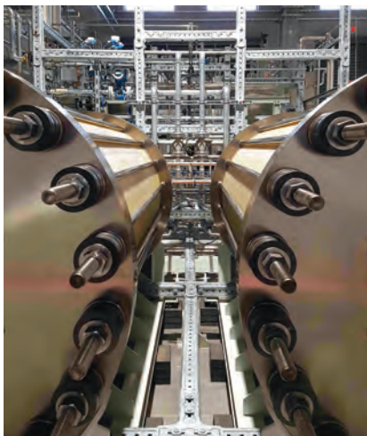
Der Wasserstoff wird CO 2 -neutral in einem Elektrolyseur mit Strom aus Wasserkraft hergestellt. Bild: Haas Engineering GmbH & Co. KG
