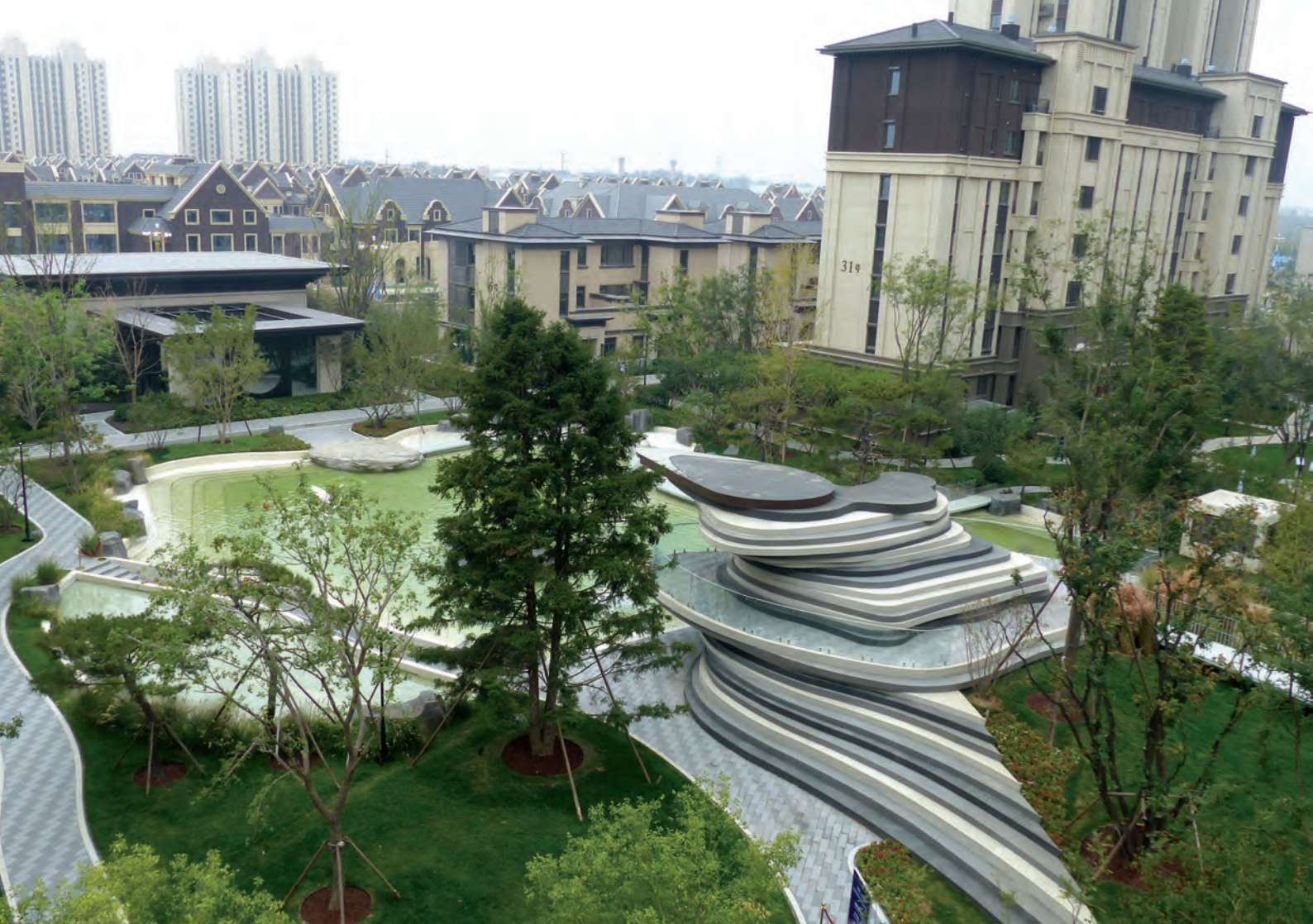
Die Bahnstadt in Gaobeidian: Im ersten Bauabschnitt entstanden in dieser Siedlung 300.000 Quadratmeter Wohnfläche im Passivhaus-Standard, und das in drei Jahren. Bild: Passivhaus Standard
