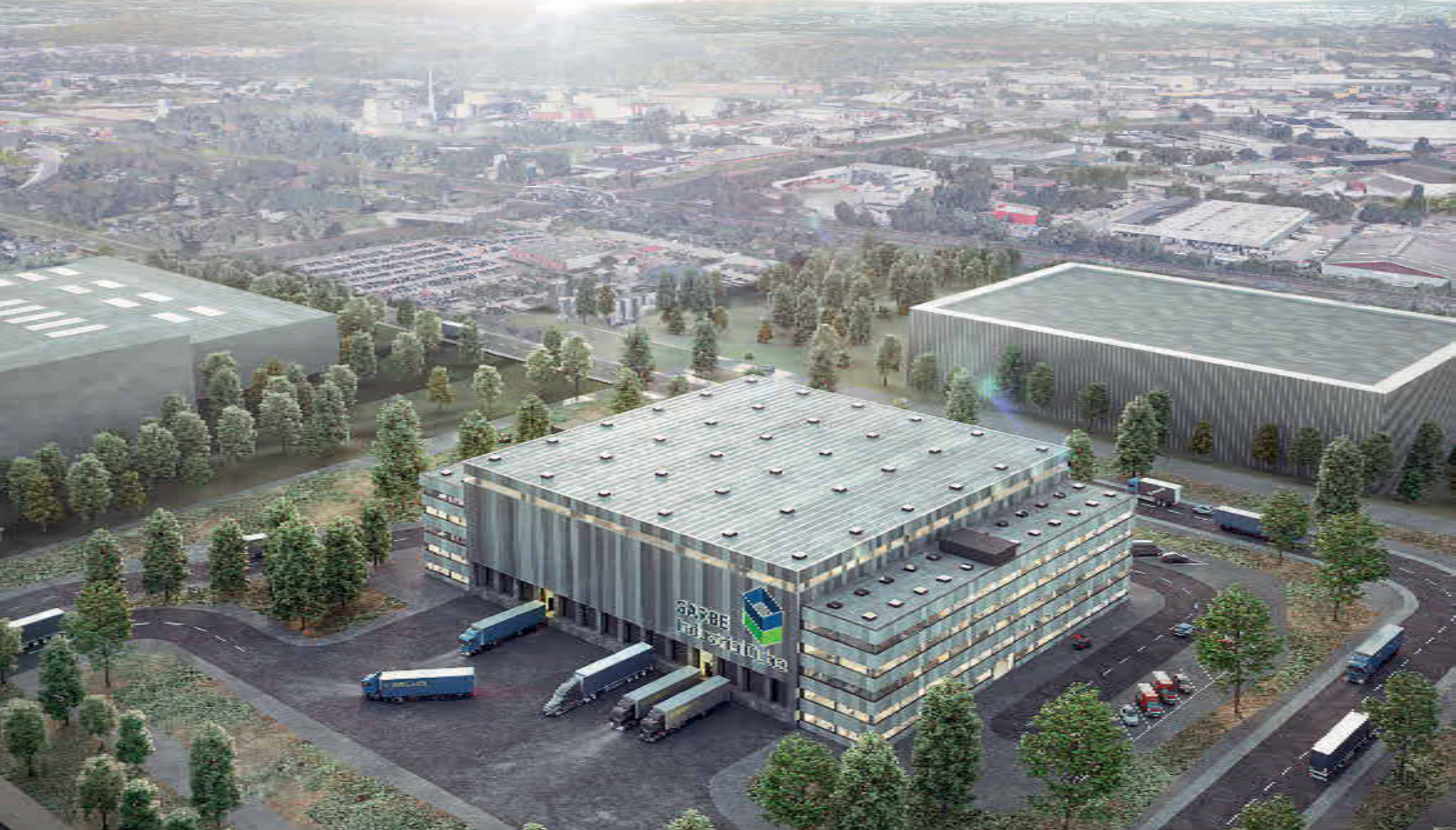
Bild 1 Der Garbe IndustrialCube kombiniert die miteinander verträglichen Funktionen Logistik und Gewerbe unter einem Dach. Bild: Garbe Industrial Real Estate GmbH
