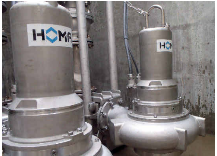
Die verschiedenen Edelstahl-Tauchmotorpumpen der Baureihen CH, CTP, CMX, CV, CVX, CK der Homa Pumpenfabrik – konzipiert mit Druckanschlüssen von 2" bis DN 150 – eignen sich für den Dauerbetrieb z. B. in der chemischen Industrie und bei der Entsorgung chemisch belasteter Abwässer. (Bild: Homa Pumpenfabrik)
