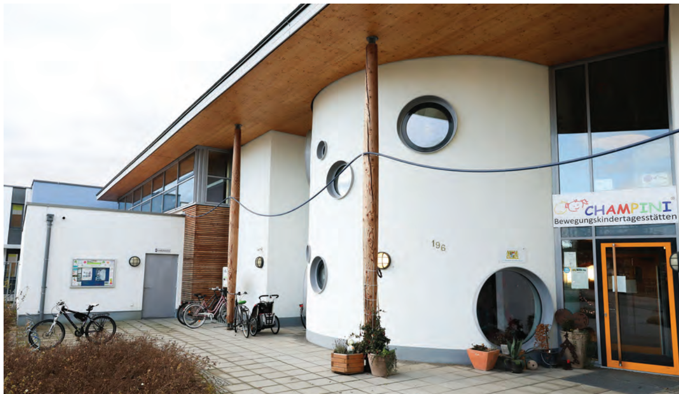
Bild 1: Bei der Erweiterung der Kita Champini setzten die Verantwortlichen auf ein individuelles Konzept für den Sanitärbereich. Bild: Geberit
