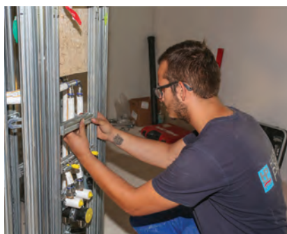
Bild 4: Auf der Baustelle wurden die Rondelle aufgestellt, zusammengebaut und die Rohrleitungen und Anschlüsse integriert. Dank Vorfertigung konnte dies mit nur zwei Installateuren in kurzer Zeit geschafft werden. Bild: Geberit
