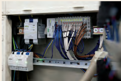
Bild 3: Die neu installierte Lichtsteuerung ermöglicht die Einbindung von Leuchten und Sensoren und kann durch ihre Modulbauweise bedarfsgerecht erweitert werden. Bild: Wago
