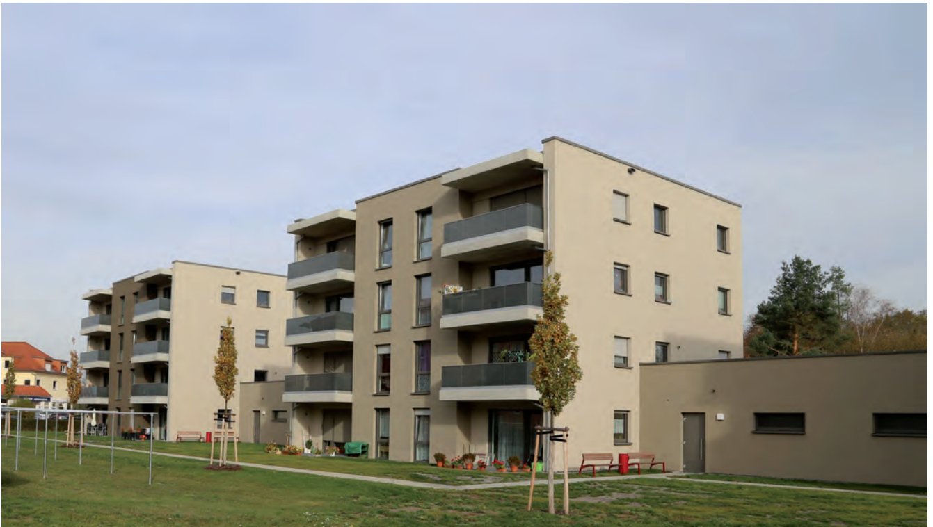
Bild 1: In den Stadthäusern in Stadtroda kommt eine ganzheitliche Systemlösung für Wärmekomfort und Trinkwasserhygiene zum Einsatz. Bild: K&R Ingenieur + Planungsbüro
