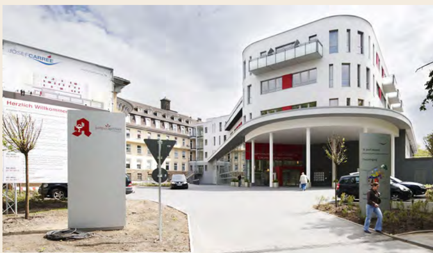
Gerade in Gebäuden mit gemischter Nutzung spart eine übergreifende Regelung für das Lüften, Heizen und Kühlen viel Energie. Aber die Realisierung scheitert oft an den Gewerke-Grenzen.
