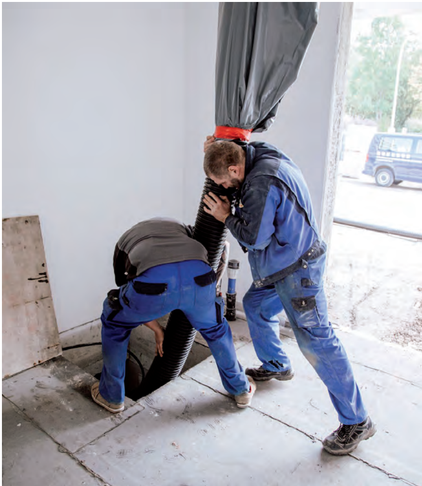
Bild 2: Ein einfaches und schnelles Einbringen in den Versorgungs- und Medienschacht ermöglichte die hohe Flexibilität der Rohrleitungen für die Wärme- und Wasserversorgung. Bild: Uponor
