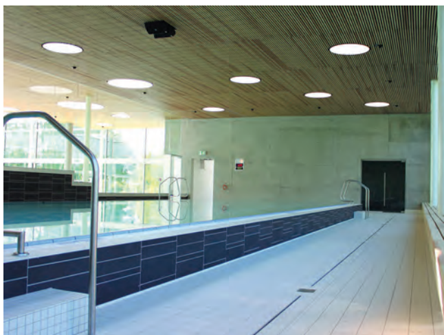
Bild 2: Um das sanierte Kursbecken mit Hubboden verläuft die kaum sichtbare Entwässerungsrinne. Bild: Aschl GmbH, Pichl bei Wels
