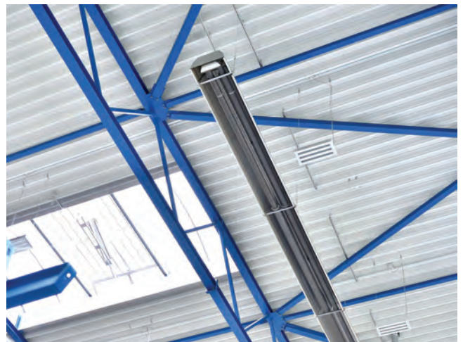
Bild 2: Die Dunkelstrahler modulieren im pneumatischen Gas-Luftverbund stufenlos zwischen 40 und 100 Prozent Leistung und passen so die Leistung dem tatsächlichen Wärmebedarf an. Bild: Schwank
