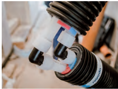
Bild 3: Für die rechtwinklige Verbindung der Rohrenden wurde die Quick & Easy-Technologie eingesetzt. Bild: Uponor
