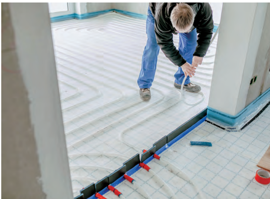
Bild 5: Bei der Flächenverteilung in den Wohnungen kam ein Klett-Fußbodenheizungssystem zum Einsatz, das sich schnell und einfach verlegen lässt. Bild: Uponor
