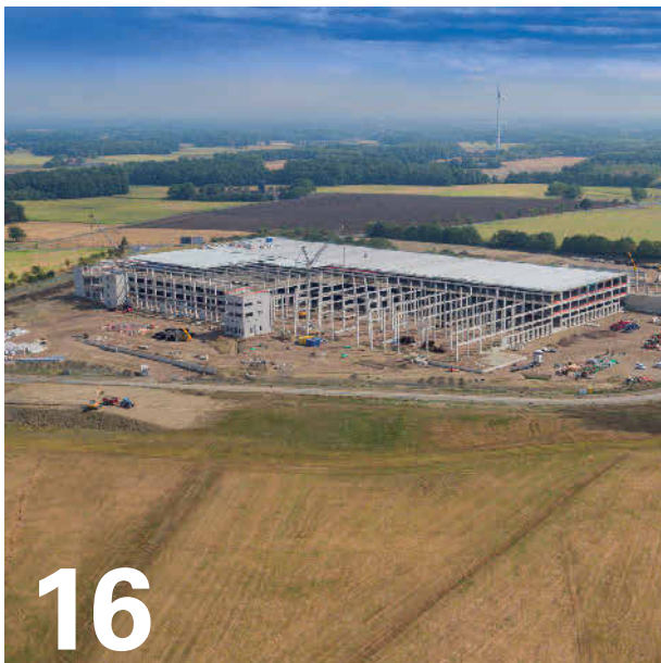
5 500 Fertigteile verbaut Max Bögl für ein großes Logistikzentrum in Oelde. Abb.: Firmengruppe Max Bögl – Luftbild Crew Hamburg
