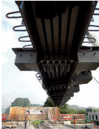
Das Einheben einer Dehnfuge erfolgt mit einem 100-Tonnen-Kran. Abb.: MAURER
