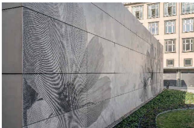
Um die Platten dünn gestalten zu können, setzten die Verantwortlichen die Carbonfasern von Solidian ein. Abb.: Steffen Spitzner/Hentschke Bau GmbH
