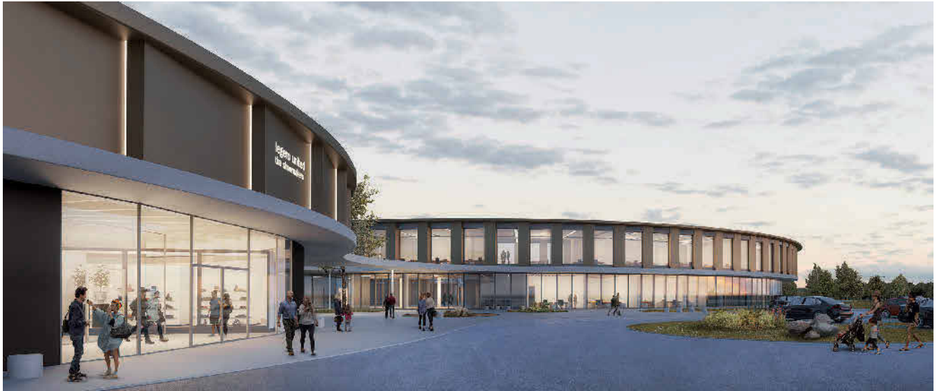
Eine Holz-Beton-Konstruktion ermöglicht den offen und flexibel gestaltbaren Campus für legero. Abb.: legero united
