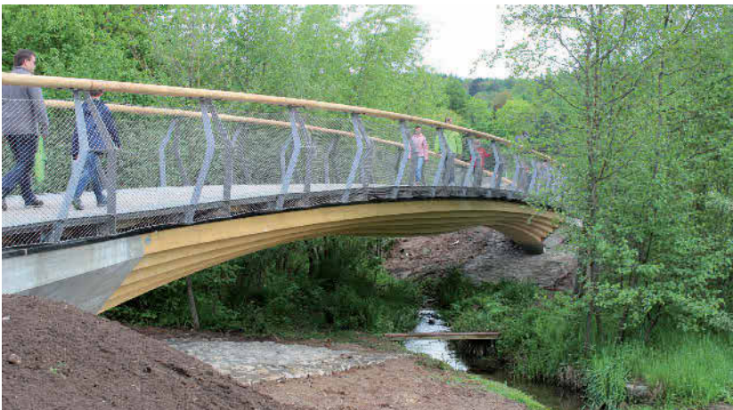
Drei innovative Fußgänger- und Radwegbrücken entstanden im Remstal in filigraner Holzbauweise. Sie wurden nach dem Konzept der „Stuttgarter Holzbrücke“ konstruiert.
