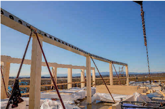
Das gesamte Gebäude ist von einem Holztragwerk überspannt. Abb.: Peikko
