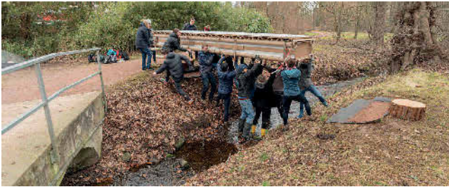
Bild 12. Montage der Brücke von Hand Abb.: J. Rau Fig. 12. Erection from hand Source: J. Rau
