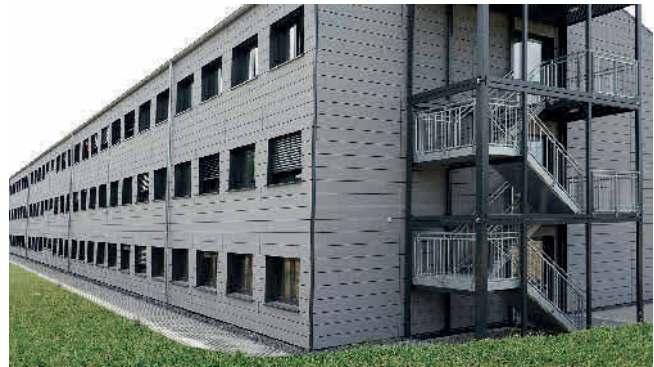
Eine hinterlüftete Eternit-Vorhangfassade prägt das temporäre Systemgebäude. Abb.: SÄBU Morsbach
