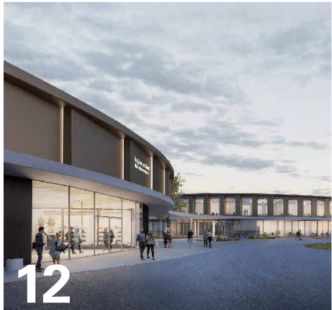
12 Eine Holz-Beton-Konstruktion ermöglicht den offenen und flexibel gestaltbaren Campus für legero. Abb.: legero united
