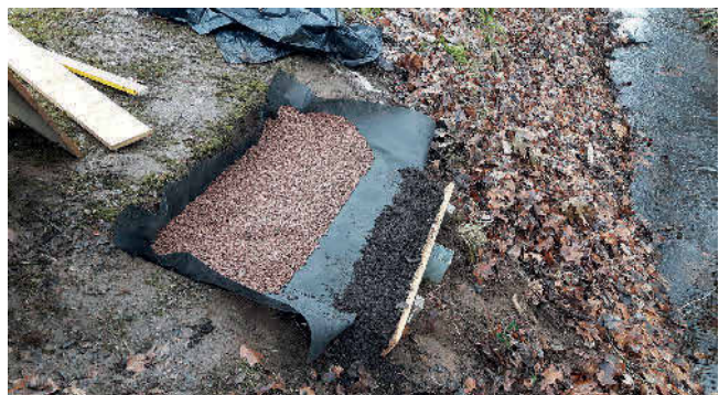
Bild 11. Stützen der Böschung (a), Vorbereitung des Erdreichs und Kiesauflage am Auflagerpunkt (b) Abb.: A. Becker Fig. 11. Bearing area (a), preparation with gravel (b) Source: A. Becker
