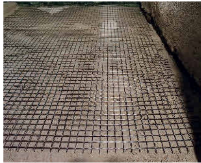
Mit dem Laminierverfahren wurde das Carbon-Gelege eingearbeitet. Abb.: Detlef Koch
