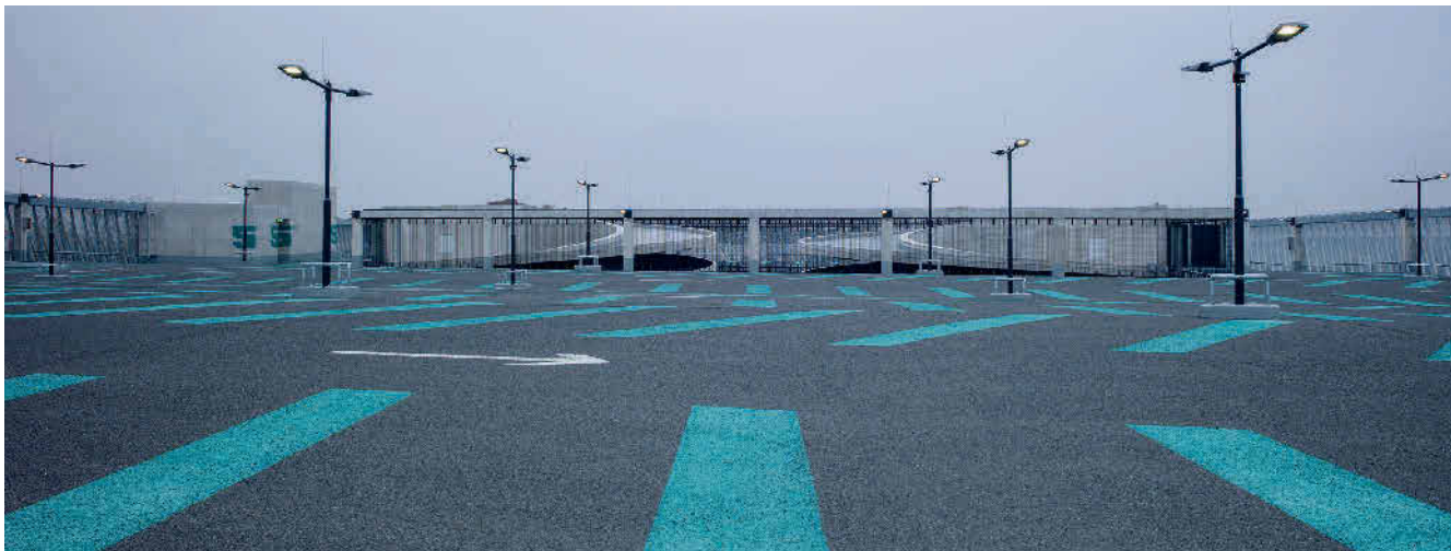
Gussasphalt als Abdichtung in Verbundbauweise schützt die Betonkonstruktion vor dem Eindringen von Chloriden. Abb.: HOFMEISTER Gussasphalt GmbH & Co KG
