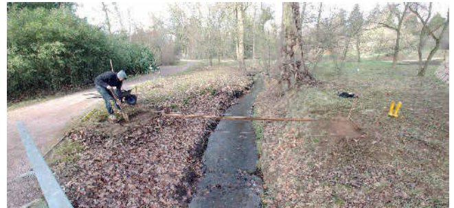
Bild 1. Standort Abb.: A. Becker
