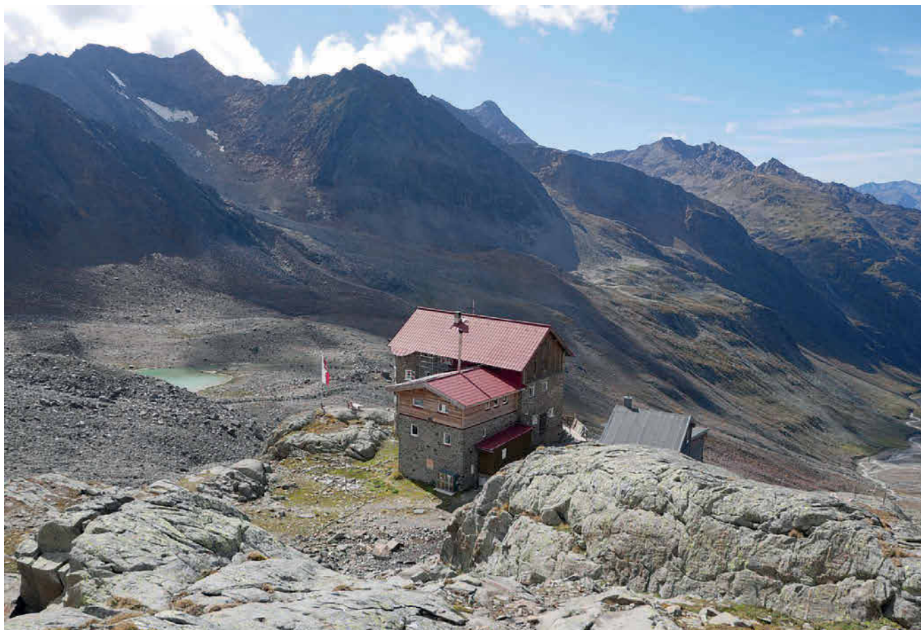
Mit Carbonbeton konnte die Siegerlandhütte auf den Stubaier Alpen saniert werden. Abb.: Detlef Koch
