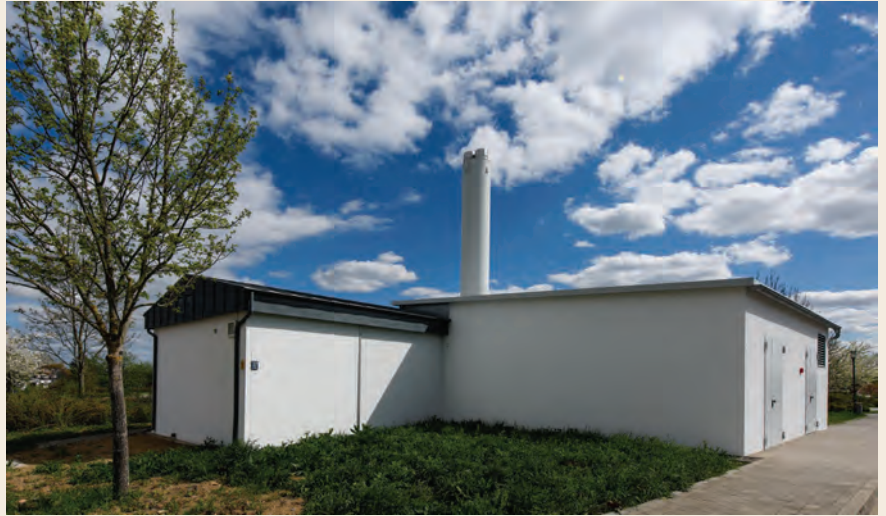
Im zentralen Heizhaus sind das BHKW, die Gas-Brennwertkessel sowie die Pufferspeicher untergebracht. Bild: Buderus
