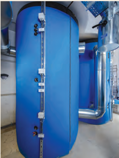
Die beiden Pufferspeicher haben ein Fassungsvermögen von je 5500 l. Bild: Buderus
