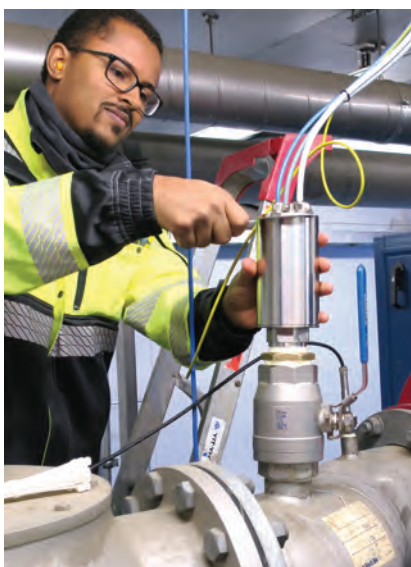
Montage des neuen Vaisala MGP261 direkt an der Biogasleitung im finnischen Entsorgungszentrum Ämmässuo. Bild: Vaisala
