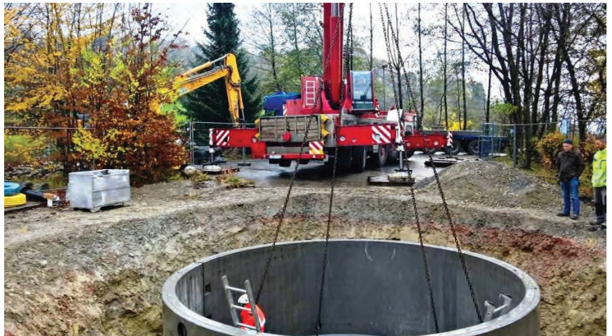
Versetzen des unterirdischen Pelletspeichers aus Betonfertigteilen, Fassungsvermögen 45 m 3 beziehungsweise 28 t, mit bauseitigem Autokran. Bild: Mall
