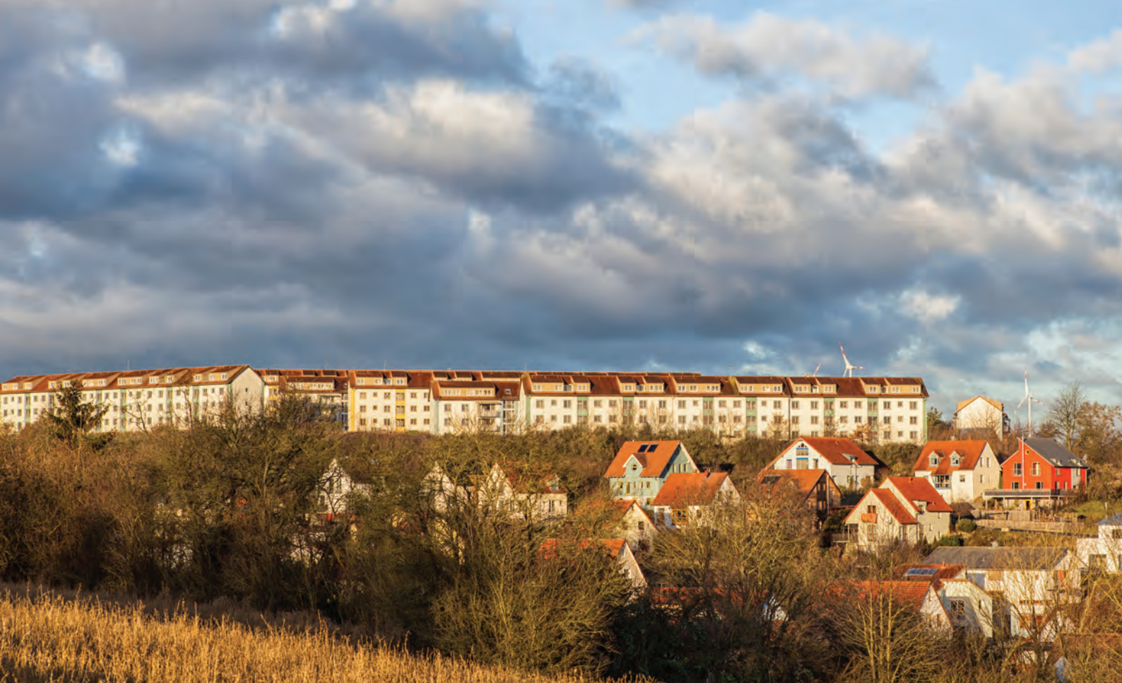
Die Wohnsiedlung Marshall Heights in Kitzingen stand nach Abzug der US Army leer. 2016 zogen die ersten neuen Bewohner ein. Bild: Depositphotos.com/Haenson
