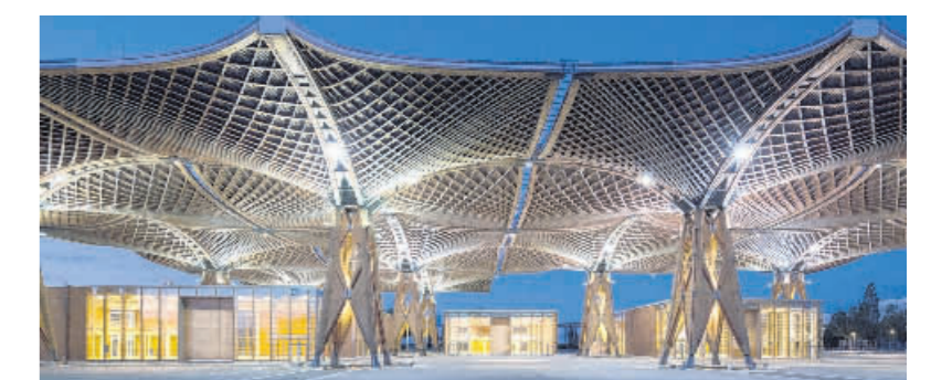
Das Expo-Dach, die futuristische Holzkonstruktion auf dem hannoveraner Messe-gelände, wird Zentrum der neuen Cebit. Foto: Deutsche Messe
